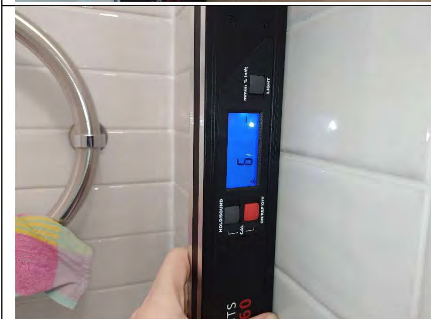
Фото №11. Измерения уровня стен в ванной комнате.
