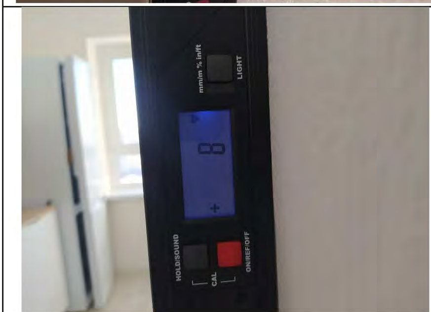
Фото №9. Измерения уровня стен в кухне.
