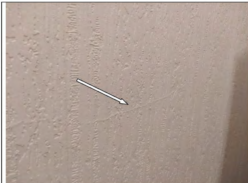
Фото №49. Замытие обоев в гардеробной.
