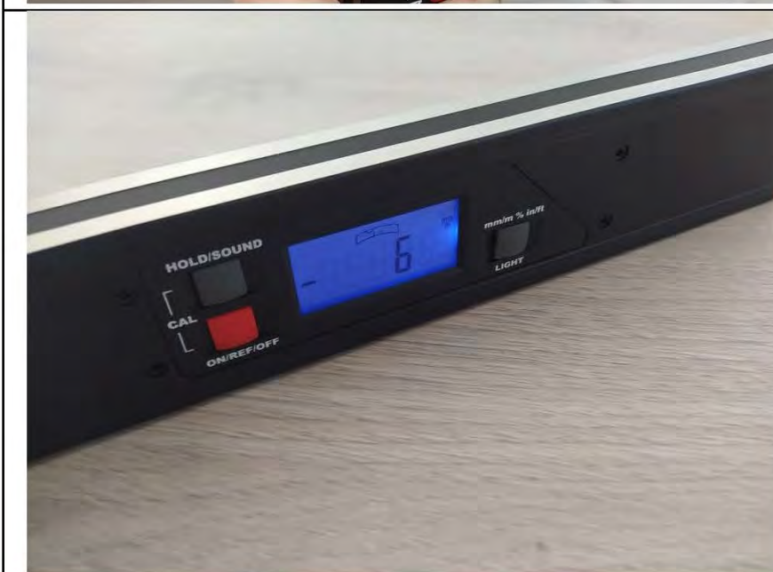
Фото №12. Измерения уровня напольного покрытия в спальне.
